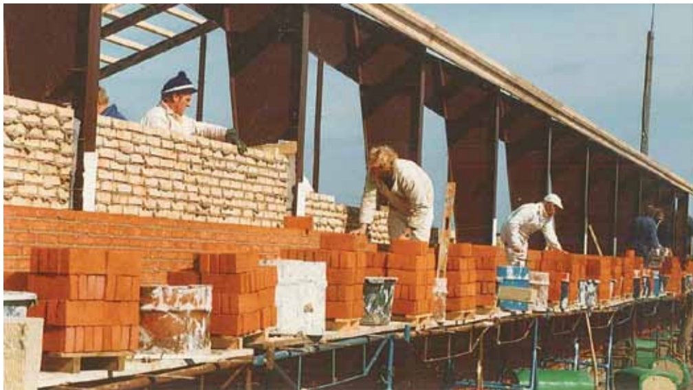
Karl Otto Damsgård fortæller, at der var ca. 25 personer i gang ved støbningen og ca. 10 murere ved murerarbejdet.
